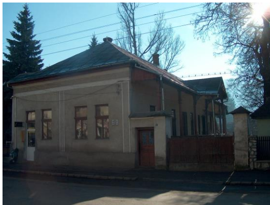
Casa Parohiala - proprietate Parohia Romano Catolica - 1/2 sec.XIX - B-dul Granicerilor; nr. 16
