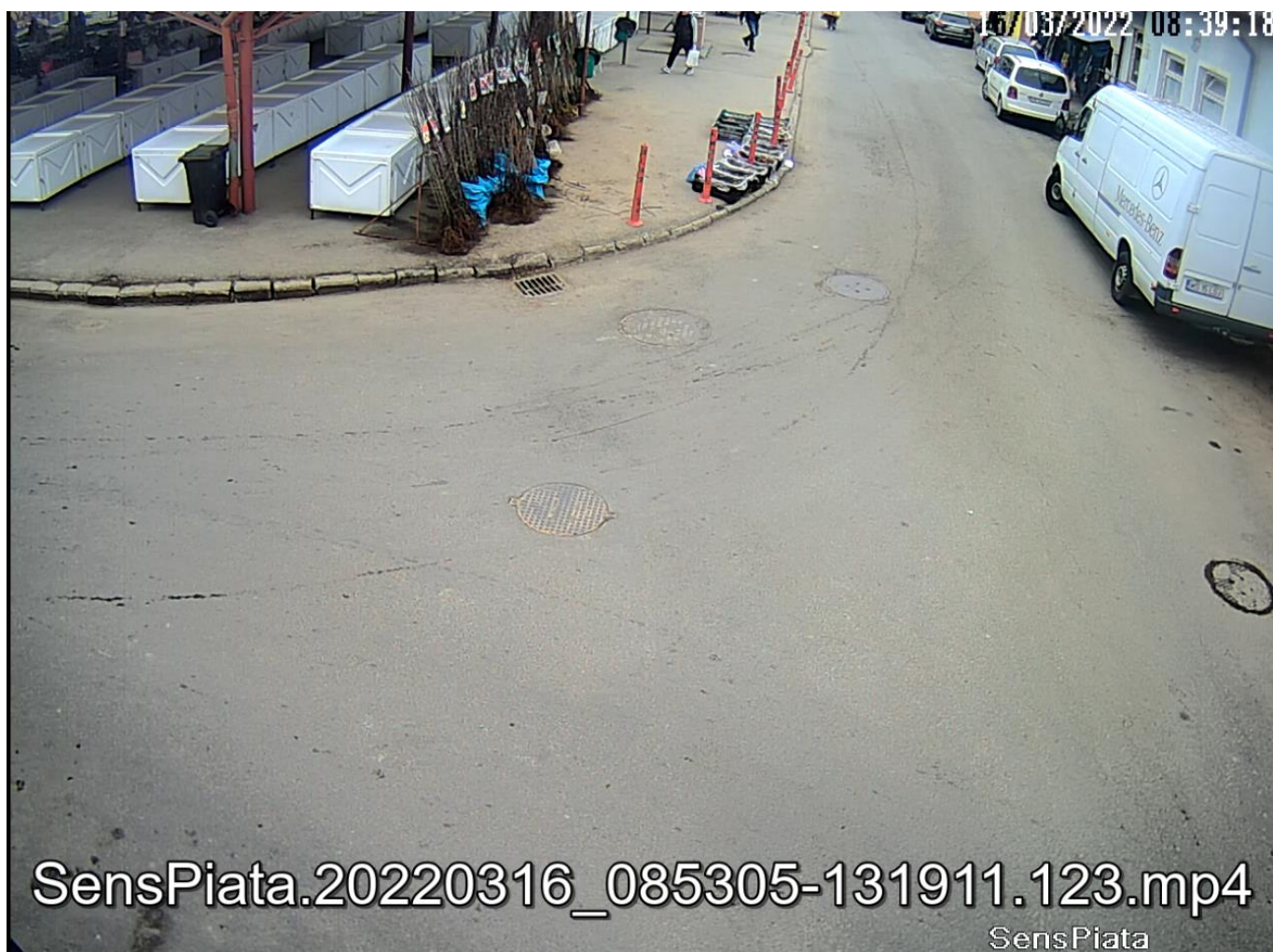
Figura A1 - 36 Intersecția 19. Amplasament
